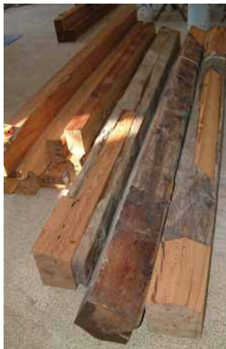
La réparation de poutres grâce à des prothèses faites sur mesure permet de conserver en grande partie la matérialité originale du bâtiment. Église de la Pobla de Benifassà (prov. de Castellón, Espagne).
