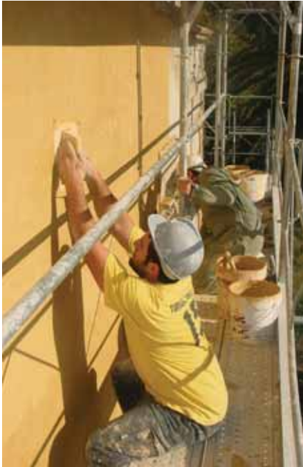
8. Application de stuc traditionnel sur la façade du bâtiment.
