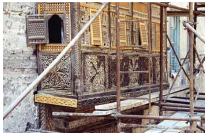
Travaux de menuiserie : restauration du grand moucharabieh de la maison Sennari, Le Caire, Egypte.
