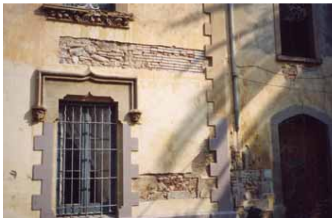
2. Carottage réalisé dans le mur de façade du bâtiment pour en connaître la composition constructive.
