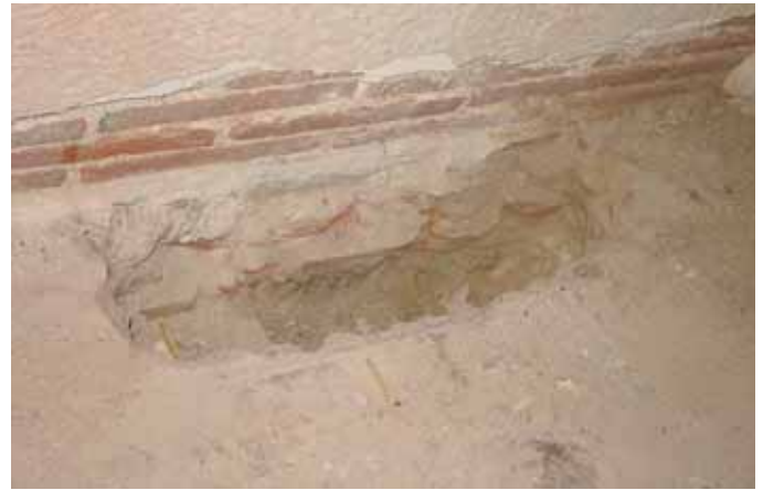
5. Carottage réalisé pour analyser le terrain sous les fondations du mur en brique pleine.
