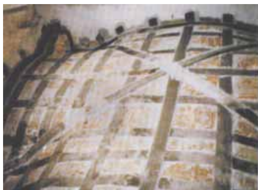
Renforcements de voûtes par des polymères à fibre renforcée (PFR)
