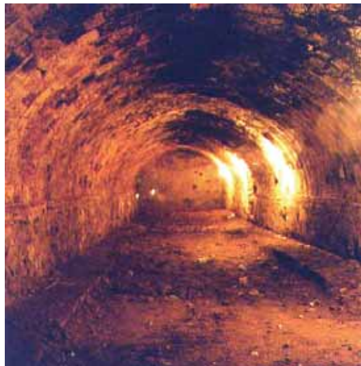
Une masse d'air enterrée et en principe sèche (grotte, crypte, etc.) attire vers elle la vapeur d'eau du terrain qui l'entoure.
