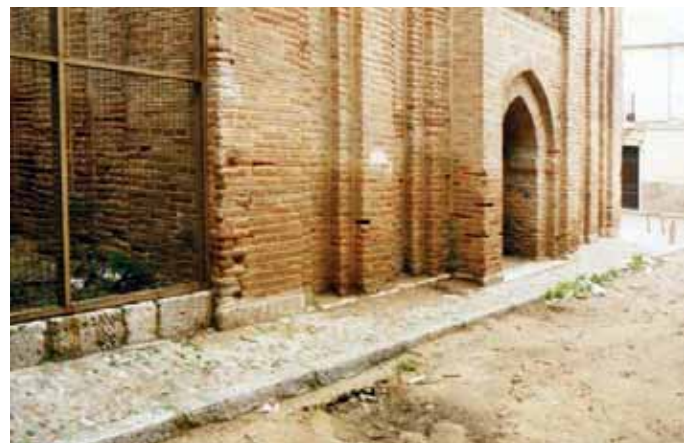
Humidité par condensation hygroscopique.
