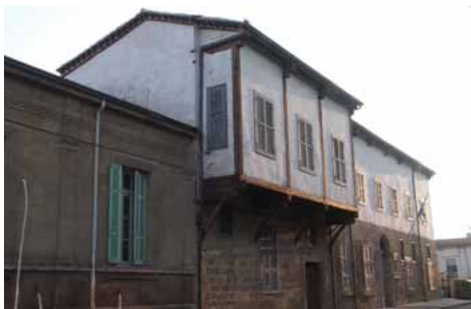
Mur de matériaux légers (ntolmas – structure de bois avec remplissage de plâtre, de roseaux et de pierre) (Nicosie)
