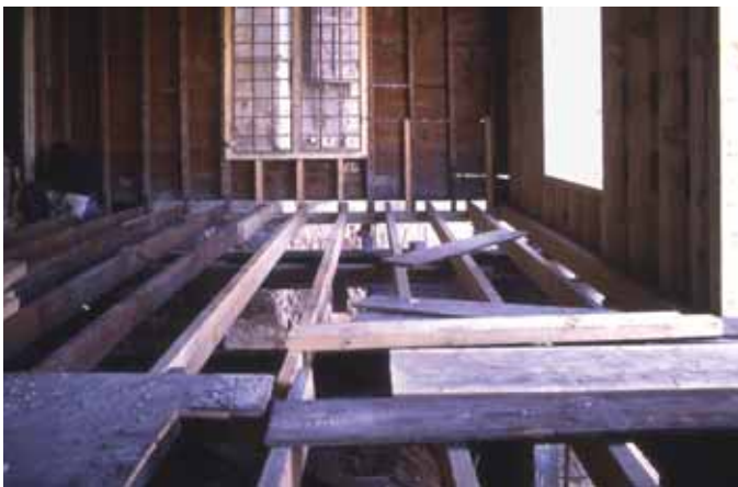
Intérieur, au stade de la réhabilitation, montrant une bonne condition physique
