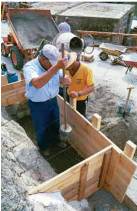
Restauration d'un mur de terre sur la rive nord de la Méditerranée, en utilisant la technique traditionnelle de construction. La Peza (prov. de Grenade, Espagne).
