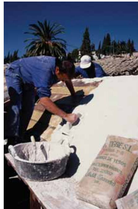
L'application d'une couche de plâtre sur l'armature de la couverture de bois avant de recevoir les tuiles constitue une technique traditionnelle qui est en cours de récupération dans les travaux de réhabilitation. Quartier de l'Albaicín à Grenade (Espagne).
