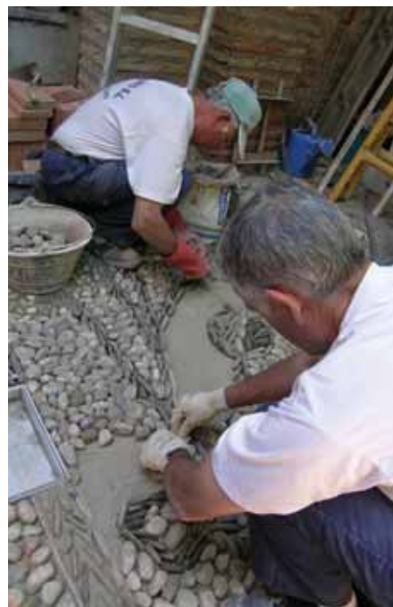
Restauration du pavage grenadin en conservant la technique traditionnelle. Quartier de l'Albaicín à Grenade (Espagne).
