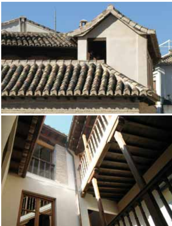
La restauration des bâtiments du quartier est effectuée en ayant recours aux techniques traditionnelles, en récupérant la typologie originale et en l'adaptant aux nouveaux besoins des usages contemporains. La cour intérieure de la maison mauresque traditionnelle a été dotée d'une couverture de verre, ce qui permet la climatisation de l'espace et son incorporation au logement. Quartier de l'Albaicín à Grenade (Espagne).
