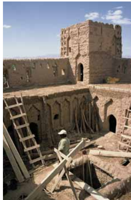
La restauration de la casbah Ait Ben Moro pour son usage comme habitat touristique a été effectuée avec des matériaux et des techniques traditionnels. Skoura (Maroc).
