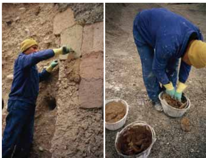
La préparation de tests de mortier pour trouver la texture et la couleur adéquates dans un revêtement traditionnel constitue une tâche nécessaire pour obtenir les résultats attendus. Grenade (Espagne)..
