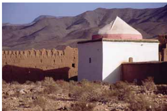
La restauration du marabout Sidi Abdellah ben Ali, situé dans le ksar de Tamnougalt, a contribué à la consolidation des symboles culturels et religieux de la population locale. Vallée du Draa (Maroc).
