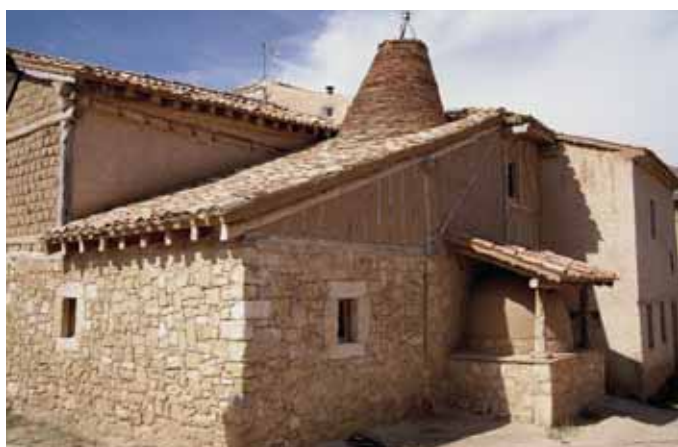
La réhabilitation de la casa pinariega –habitat typique de la zone située entre Soria et Burgos (Espagne)– a été effectuée en prêtant une attention toute particulière à l'utilisation des matériaux et des techniques de construction locaux, et en récupérant les éléments caractéristiques qui l'identifient, le four et la cheminée. Navapalos (prov. de Soria, Espagne).
