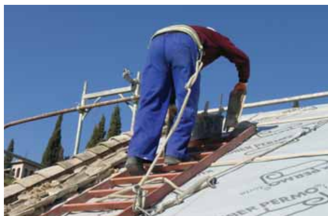
Il est nécessaire de prendre des mesures de sécurité pour éviter les accidents sur les chantiers de réhabilitation. Grenade (Espagne).
