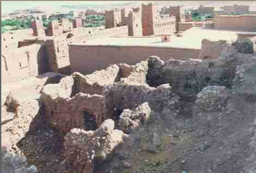
État des constructions à l'intérieur du Village
