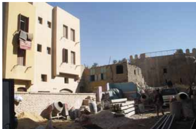
Opération de réhabilitation au Caire (Egypte)
