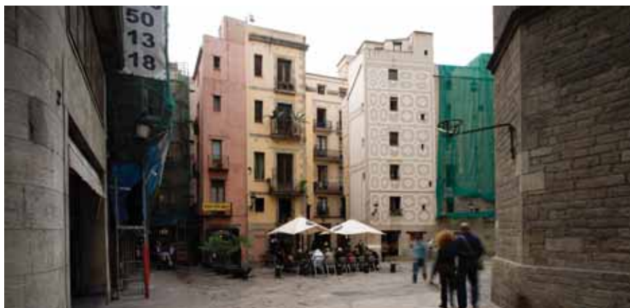
Les aides publiques ont servi à générer une importante dynamique de réhabilitation privée. Adrià Goula
